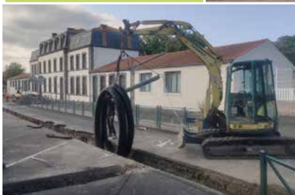
Déroulement de la canalisation du réseau de chaleur dans la tranchée.
