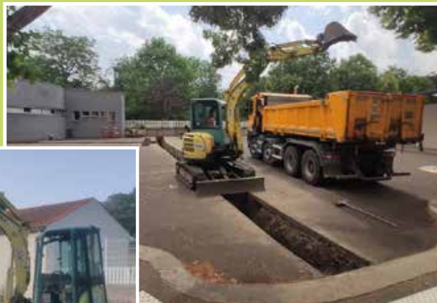
Réalisation de la tranchée dans la cour de l'école.
